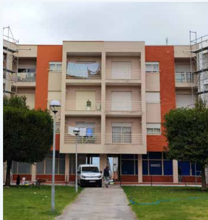
Prédio habitacional pintado por J.M Veloso com produtos Tintas Marilina
