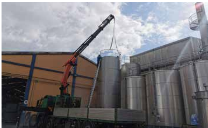
Instalação dos silos
