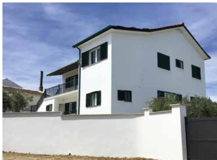
↑ Obra: Moradia Familiar // Localidade: Castelo Branco // Produtos: Limpamil, Tinta Acrílica AD // Cliente: Daniel Alexandre Rodrigues Oliveira // Comercial: Nuno Coimbra
