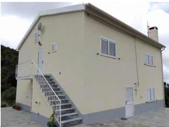
↑ Obra: Moradia Familiar // Localidade: Linhares - Celorico da Beira // Produtos: Argamassa ThermInnov 2009 Cinza, Primário IsolinaTD 564, Crepimil Extra T15 TD 564 // Cliente: Manuel Prazeres & Santos, Lda. // Comercial: António Sousa
