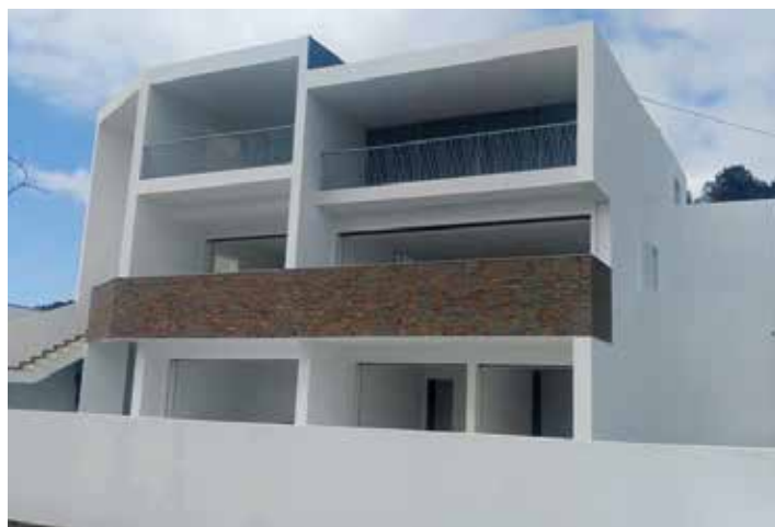
↑ Obra: Moradia Familiar // Localidade: Sintra // Produtos: Sistema ThermInnov // Ciente: J. Pinturas, Lda. // Comercial: Luís Alves
