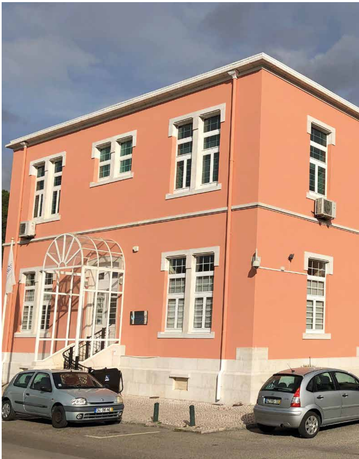
↑ Obra: Hospital Júlio de Matos // Localidade: Lisboa // Produtos: Fachada: Argamassa ThermInnov 2009, Primário Isolina,
