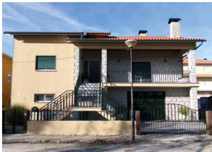
↑ Obra: Moradia Familiar // Localidade: Santa Comba - Seia // Produtos: Primário Lamurite PL, Tinta Acrílica Pura 9G Branco, TD 8579 e TD 521 | Grades: Ferrolina RAL 6009 // Cliente: J. Maltez Saraiva & Figueiredo Construção Civil, Lda. // Comercial: António Sousa
