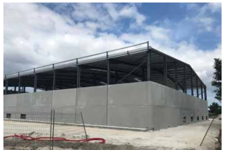
↑ Obra: Estrutura Metálica // Localidade: Marinha Grande // Produtos: Primário Epoxi Zinco 17421, Esmalte Acrílico Fosco // Aplicador: Carlos Cozinheiro, Lda. // Cliente: José de Oliveira Azevedo // Comercial: Joaquim Basto
