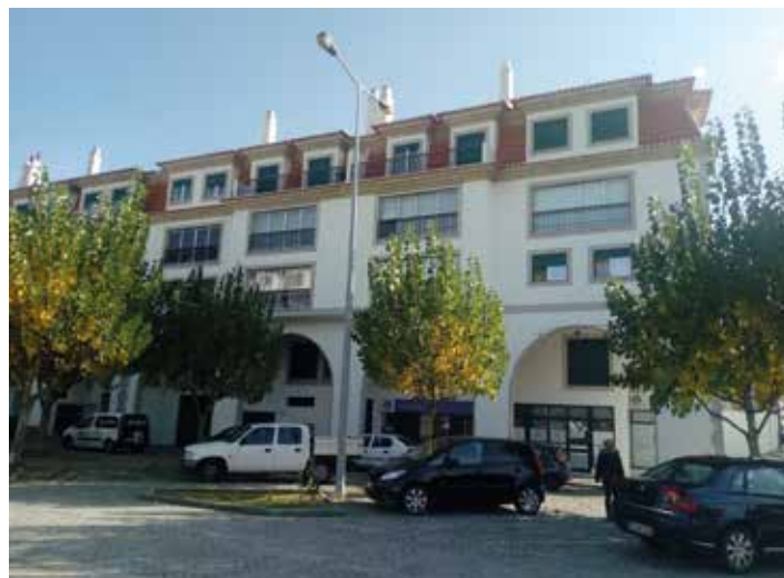
↑ Obra: Prédio Habitacional // Localidade: Nelas // Produtos: Primário Lamurite Aquoso, Elastoflex, Tinta Acrílica Pura 9G // Cliente: J. Santos, Lda. // Comercial: Luís Almeida
