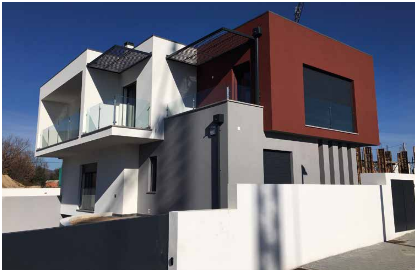
↑ Obra: Moradia Familiar // Localidade: Covilhã // Produtos: Argamassa ThermInnov 2009 Cinza, Primário Isoselante, Crepimil Extra R15 // Cliente: Francisco Vicente // Comercial: Joaquim Chaves
