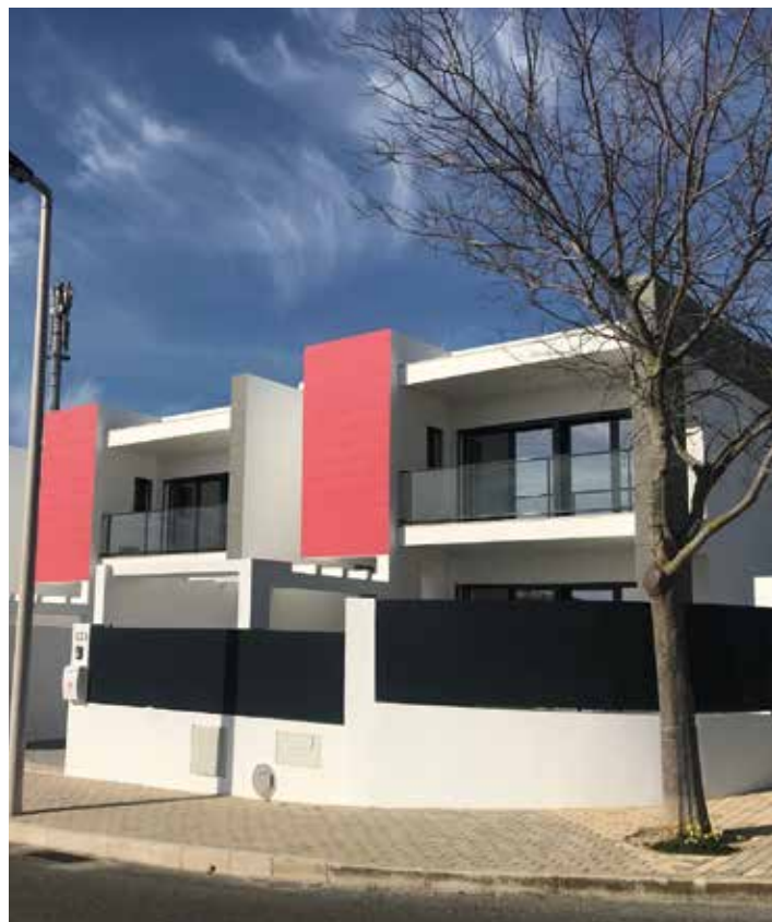
↑ Obra: Moradias em Banda // Localidade: Estoril // Produtos: Exterior: Primário Lamurite Aquoso, Tinta Texturada CC, Tinta Acrílica Pura 9G | Gradeamentos : Primário Epoximar, Esmalte PU // Ciente: Construções Micet, Lda. // Comercial: Diogo Mota
