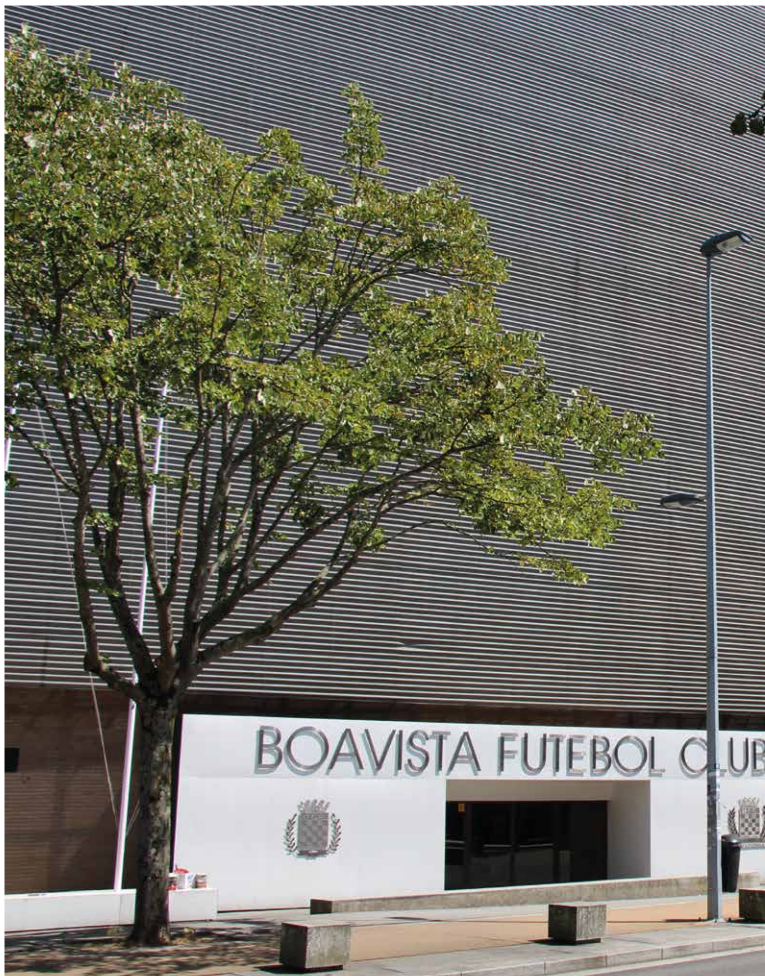
↑ Obra: Estádio do Bessa Sec. XXI // Localidade: Porto // Produtos: Plasmate Branco, Esmalte Ferromil Branco e Preto
