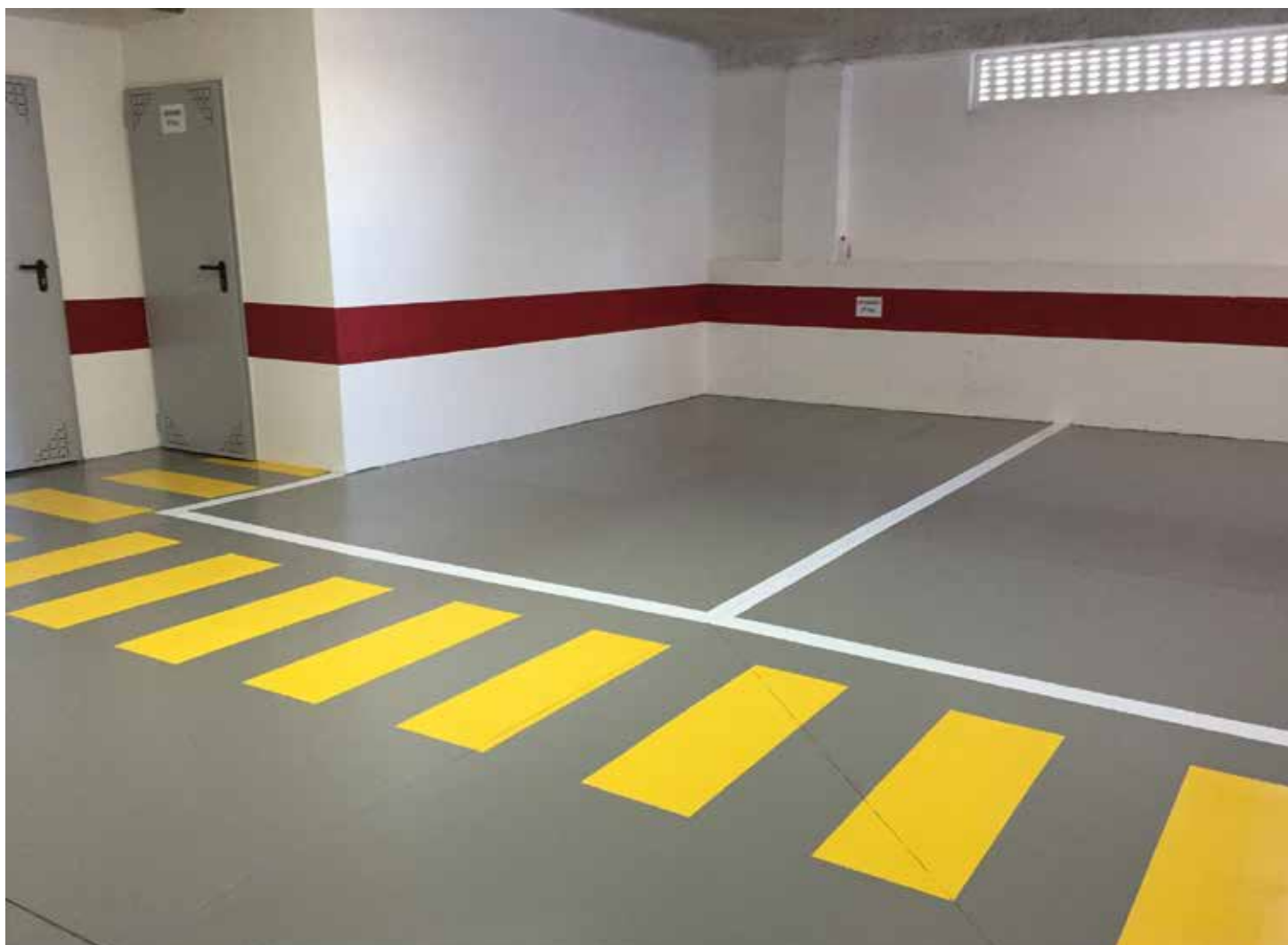
↑ Obra: Pavimento de garagem // Localidade: Castelo Branco // Produtos: Pavipex Aquoso RAL 7030, Tinta Marcação de Estradas Amarelo // Ciente: Daniel Alexandre Rodrigues Oliveira // Comercial: Nuno Coimbra
