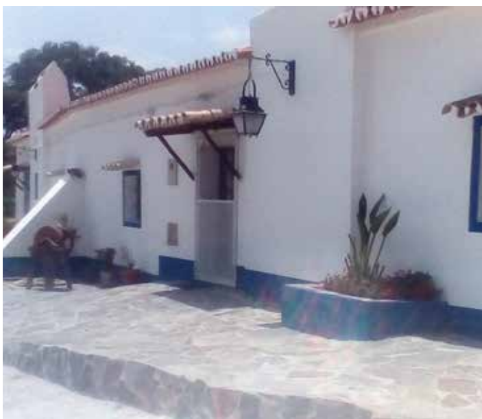
↑ Obra: Moradia Familiar // Localidade: Valverde - Évora // Produtos: Primário Pliomil Aquoso, Plastec // Cliente: Ricardo Roupa // Comercial: Vitor Neto
