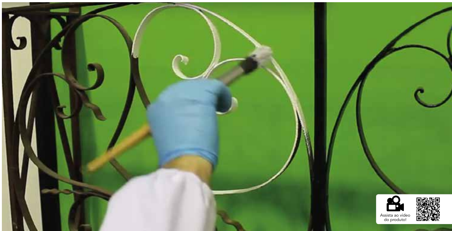
↑ Aplicação do esmalte Ferromil direto ao metal
