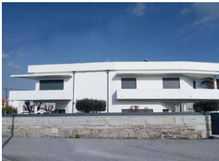
↑ Obra: Moradia Familiar // Localidade: Nelas // Produtos: Primário Lamurite Aquoso, Lináqua // Cliente: Manuel Almeida - Special Element, Lda. // Comercial: Luís Almeida
