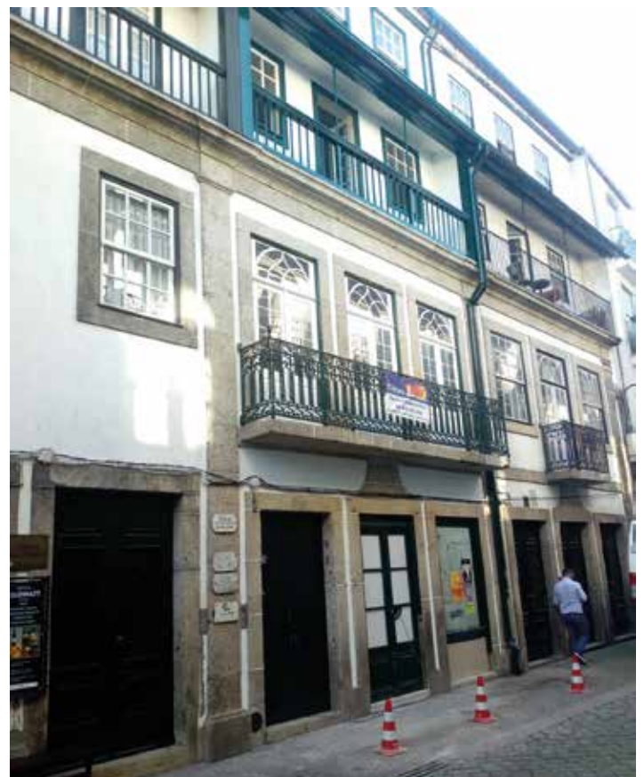
↑ Obra: Prédio Habitacional // Localidade: Amarante // Produtos: Fachada: Primário Isoselante Branco, Plastec Branco, Esmalte Mailux Brilhante Verde Garrafa | Interior: Primário Isoselante Branco, Plastec Branco, Verniz Probex Aquoso // Cliente: Agostinho Sousa Alves // Comercial: João Ribeiro
