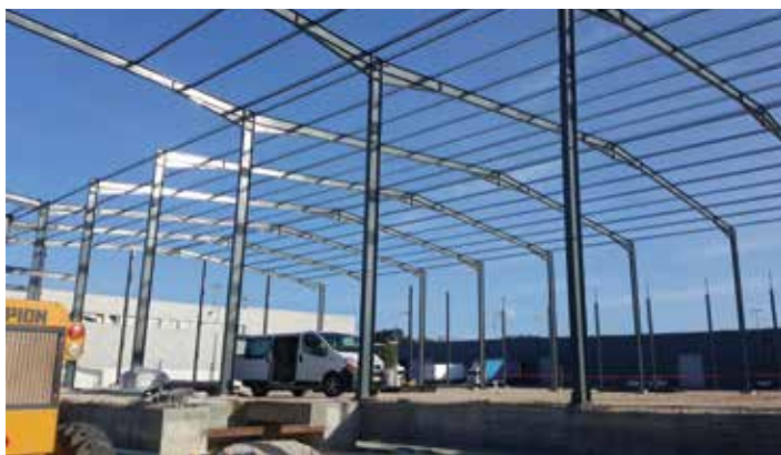
↑ Obra: Pavilhão Makro // Localidade: Coimbra // Produtos: Esmalte Policril Brillhante // Cliente: Metalomecânica Tropinchange // Comercial: José Conde
