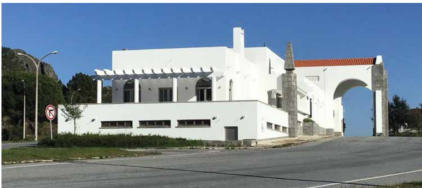
↑ Obra: Posto Transfronteiriço de Marvão // Localidade: Marvão // Produtos: Fachada: Primário Pliomil, Tinta Acrílica AD Microtex
