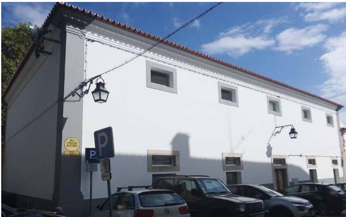
↑ Obra: Comissão Vinícola dos Vinhos do Alentejo // Localidade: Évora // Produtos: Fachadas: Primário de Silicatos, Tinta de Silicatos // Ciente: Yábura - Reabilitação e Construção, Lda. // Comercial: Vitor Neto
