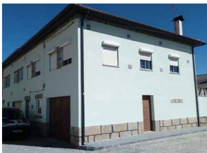
↑ Obra: Moradia Familiar // Localidade: Modoreno - Mangualde // Produtos: Exterior: Argamassa ThermlInnov 2009, Primário Isolina, Crepimil Extra, Tinta Acrílica Pura 9G | Interior: Tinta Pladur | Casas de Banho: Primário TT, Esmalte Milacril // Cliente: Luís Morgado // Comercial: Luís Almeida
