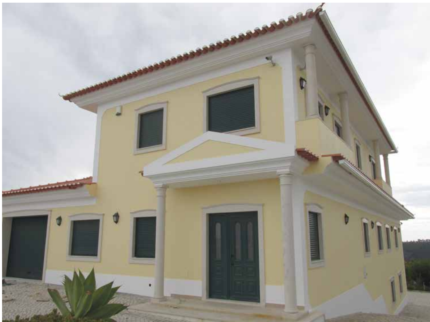
↑ Obra: Moradia Familiar // Localidade: Caldas da Rainha // Produtos: Exterior: Primário Pliomil Aquoso, Plas Super Branco e NCS S 0520-Y10R | Telhados: Hidrofugante // Cliente: Rodrigo Henriques Gomes // Comercial: Ricardo Alves
