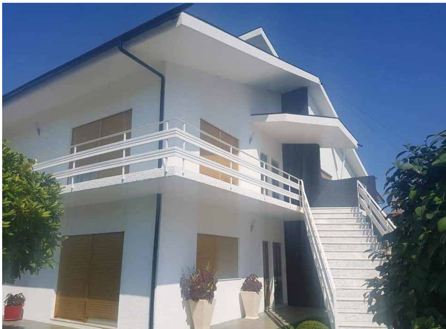
↑ Obra: Moradia Familiar // Localidade: Vila Nova de Famalicão // Produtos: Telhados: Tinta para Telhados Acetinada | Fachada: Primário Isolina, Linaqua | Gradeamentos: Primário Policril, Esmalte Policril // Cliente: Alex Construtor // Comercial: Tiago Fernandes
