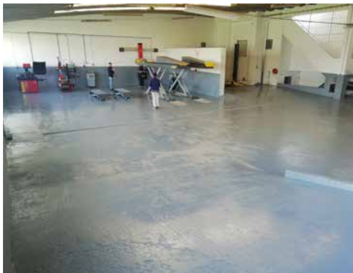
↑ Obra: Pavimento de garagem // Localidade: Faro // Produtos: Esmalte PU PAV // Ciente: Petrolapa Unipessoal, Lda. // Comercial: André Guerreiro
