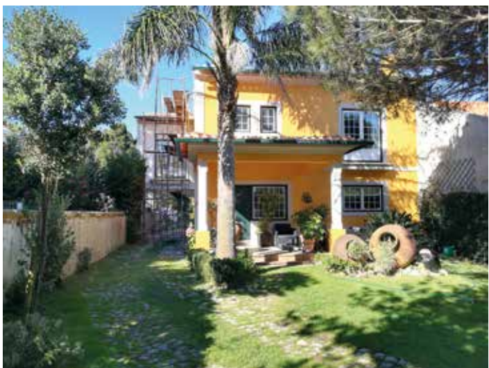
↑ Obra: Moradia Familiar // Localidade: Praia de Mira // Produtos: Primário Pliomil, Tinta Acrílica AD // Cliente: Mário Ferreira // Comercial: Mário Melo
