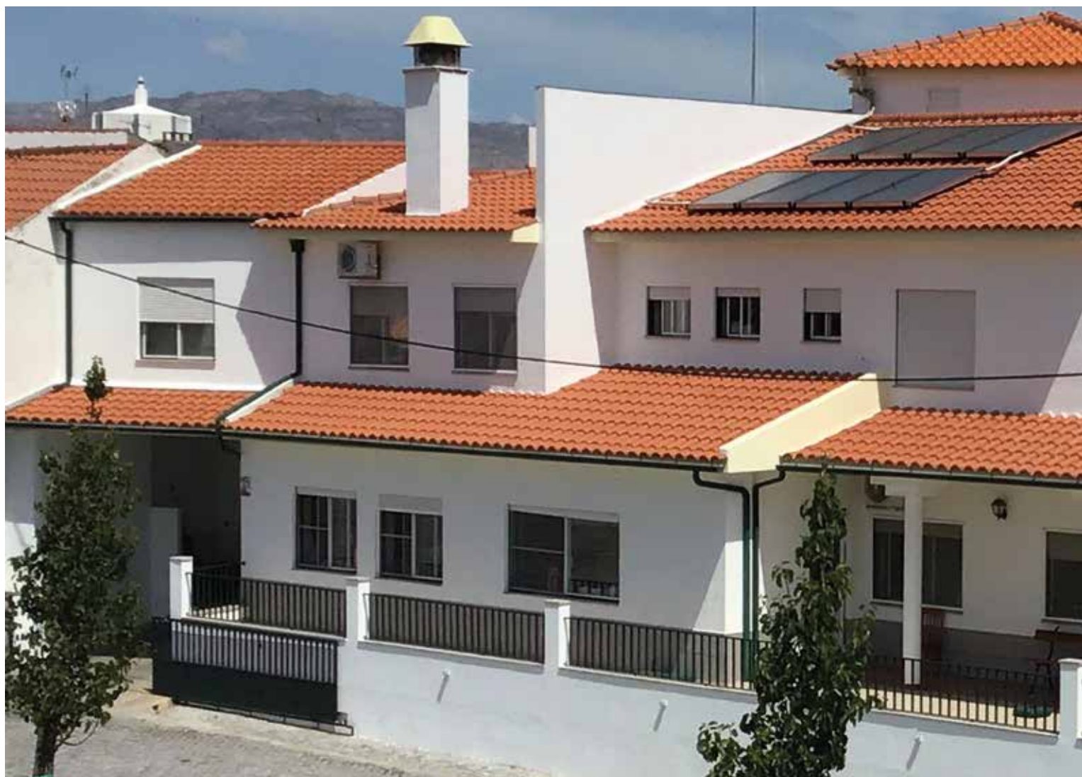
↑ Obra: Lar de Lardosa // Localidade: Castelo Branco // Produtos: Fachada: Primário Isoselante, Tinta Acrílica AD Branco | Gradeamentos:
