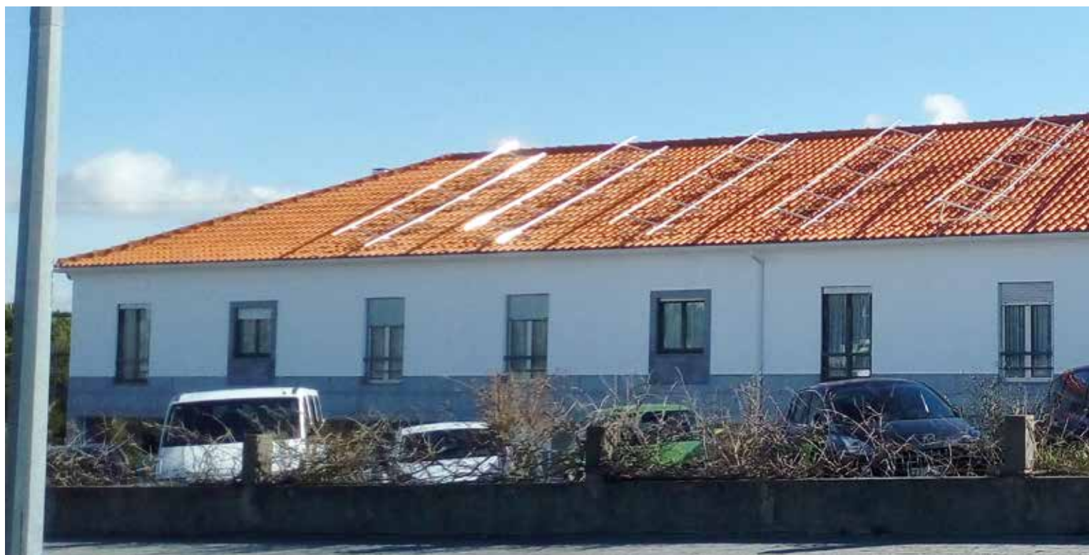
↑ Obra: Centro Paroquial de Nelas // Localidade: Nelas // Produtos: Telhado: Limpalina, Hidrofugante Aquoso Telhas | Fachada: Primário Lamurite
