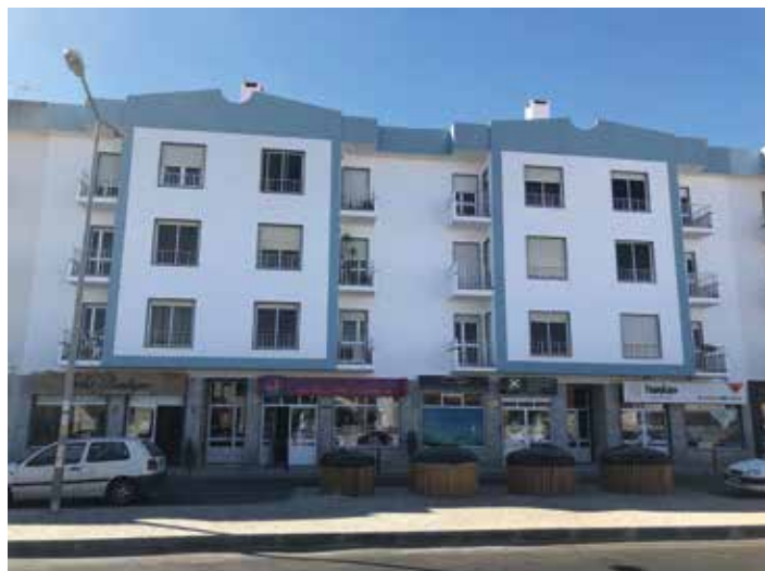
↑ Obra: Prédio Habitacional // Localidade: Mafra // Produtos: Primário Lamurite Aquoso, Tinta Texturada CC Branco e Tinta Acrílica Pura 9G Branco e Azul // Cliente: J.Pinturas, Lda. // Comercial: Luís Alves
