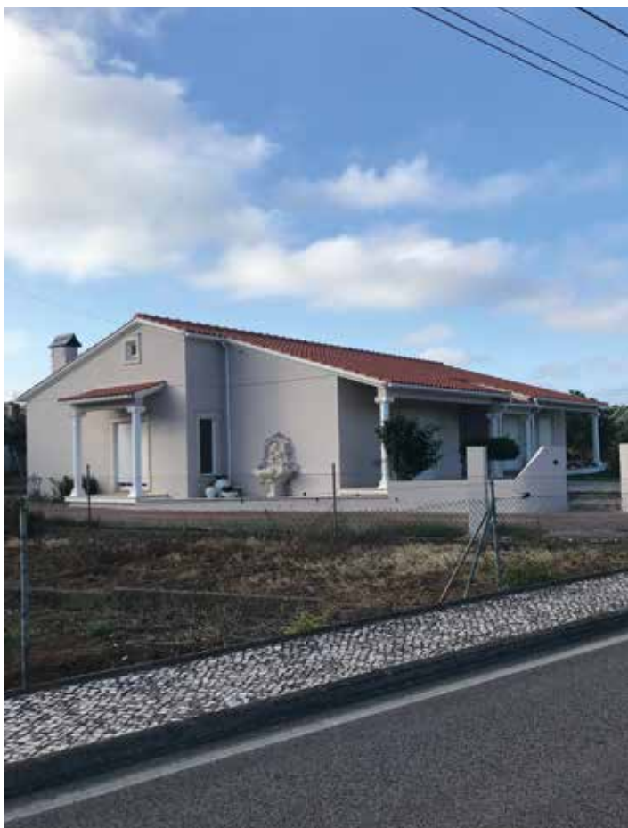
↑ Obra: Moradia Familiar // Localidade: Batalha // Produtos: Primário Pliomil Aquoso, Plas Super // Cliente: José de Oliveira Azevedo // Comercial: Joaquim Basto
