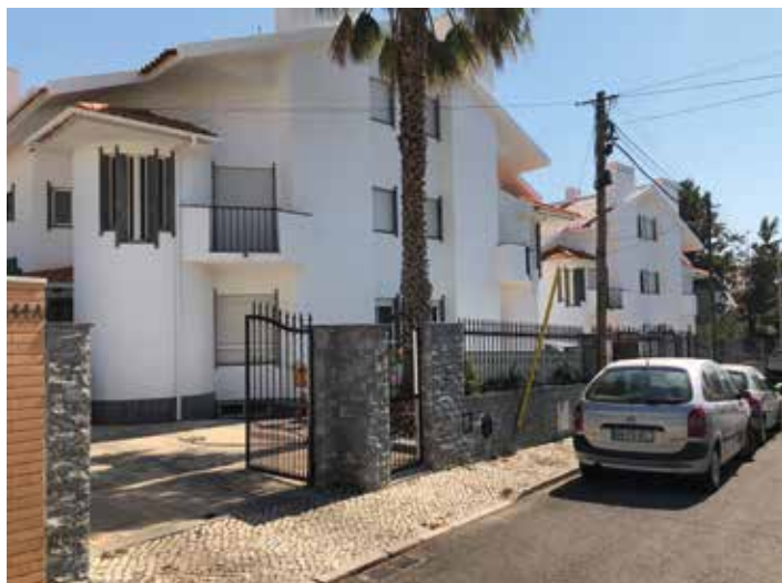
↑ Obra: Moradias // Localidade: Rana - Parede // Produtos: Limpalina, Primário Lamurite Aquoso, Tinta Texturada CC Branco, Tinta Acrílica Pura 9G Branco e Telha | Gradeamentos: Ferrolina Preto // Cliente: Machado & Machado, Lda. // Comercial: Luís Alves
