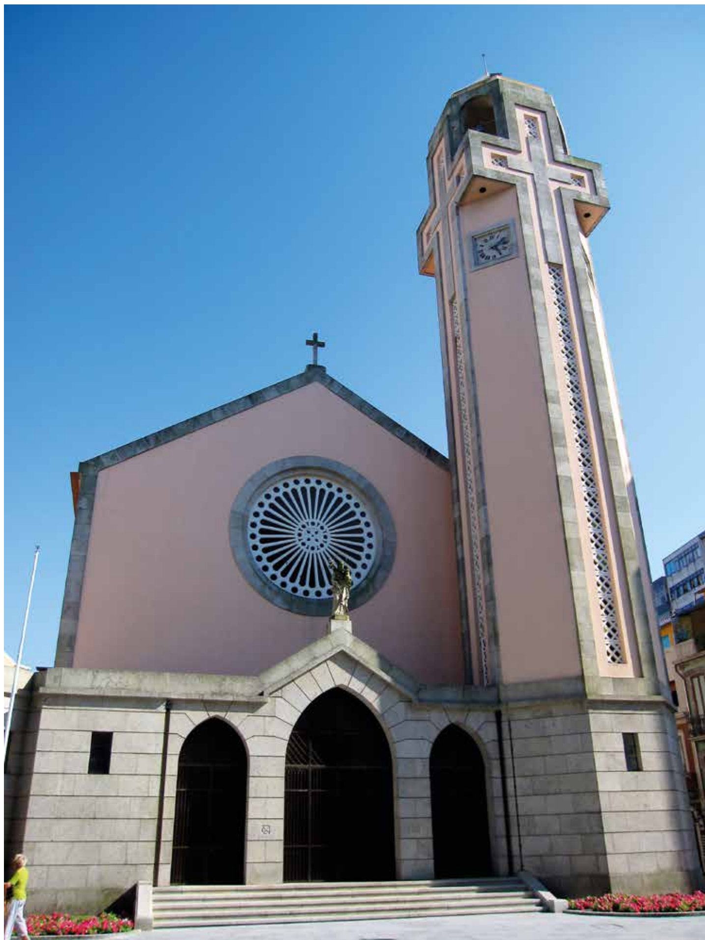
↑ Obra: Igreja Paroquial de S. José de Ribamar // Localidade: Póvoa do Varzim // Produtos: Sistema ThermInnov // Ciente: Gosto Ideal Comercial: Manuel Fernandes
