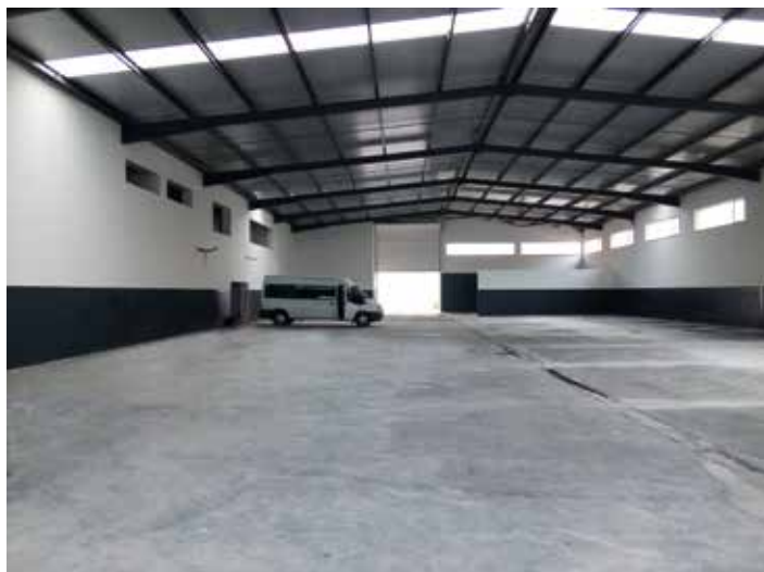
↑ Obra: Armazém // Localidade: Évora // Produtos: Primário Isoselante, Plasmil Extra, Esmalte PU PAV Ral 7011 // Cliente: Construções Alto // Comercial: Vitor Neto
