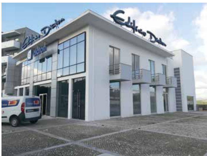
↑ Obra: Edifício Diaton // Localidade: Coimbra // Produtos: Primário Pliomil Aquoso, Supertex, Tinta Acílica AD Microtex // Cliente: Jorge Manuel Miranda Domingues // Comercial: Mário Melo
