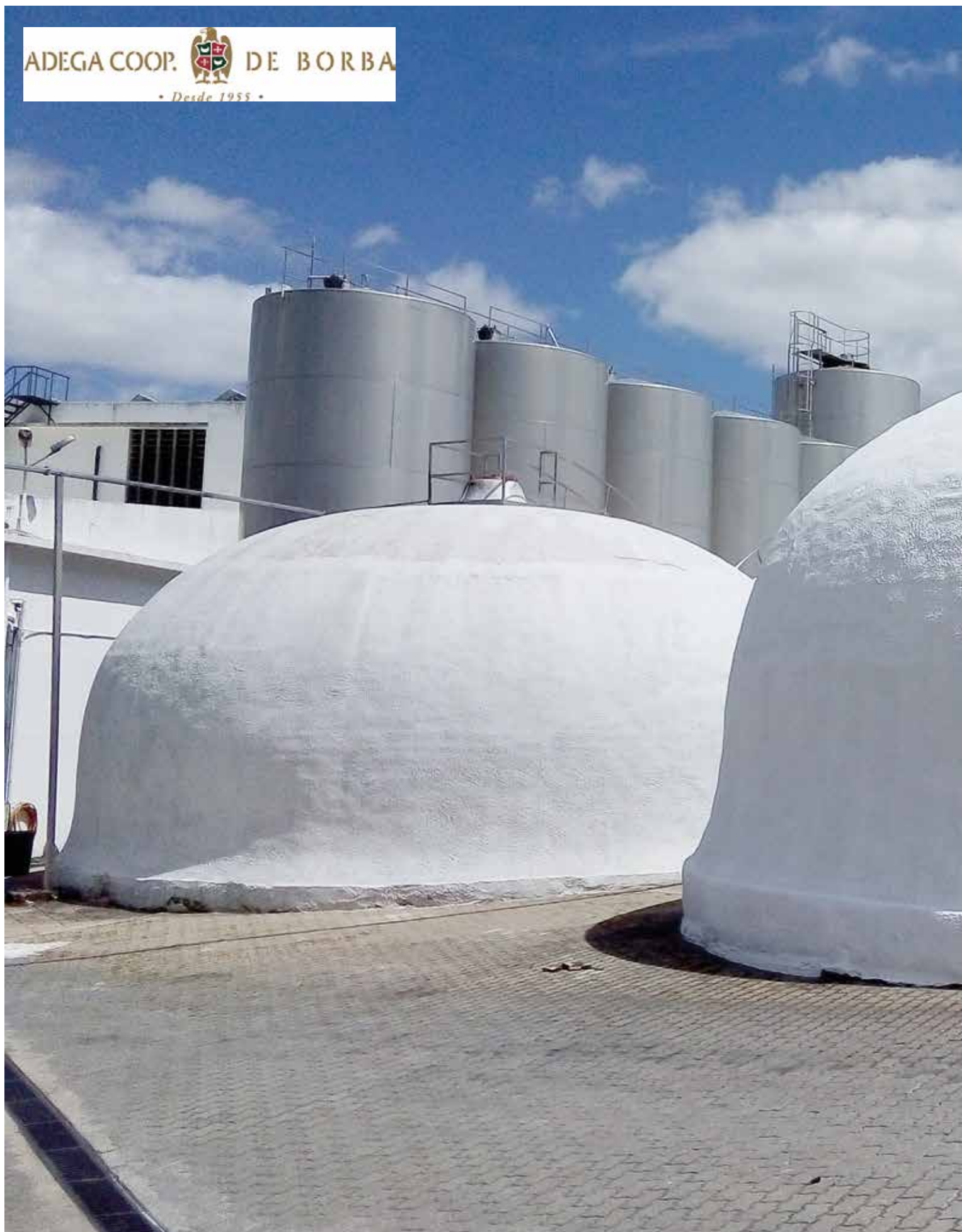
↑ Obra: Adega Cooperativa de Borba // Localidade: Borba // Produtos: Tinta Pliomil Branco no exterior dos depósitos
