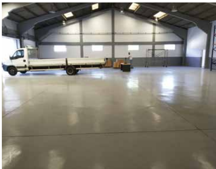
↑ Obra: Pavilhão Industrial // Localidade: Ermesinde // Produtos: Tinta PU Pavimentos // Cliente: Função Plena // Comercial: Nuno Martins
