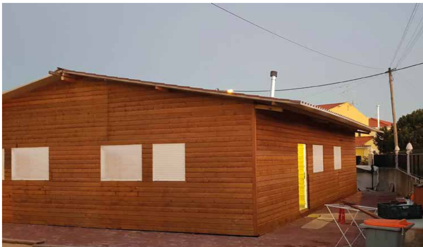
↑ Obra: Moradia Familiar // Localidade: Pêro Pinheiro // Produtos: Madeiras Interiores e Exteriores: Probex Aquoso | Chão em Madeira
