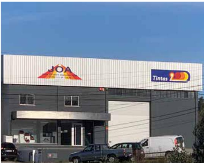
Exterior do novo armazém
