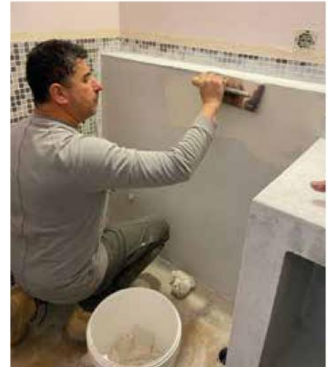
Formando a fazer a aplicação do produto em obra
