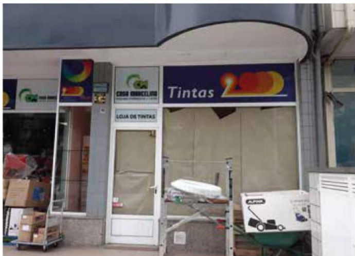
Exterior da Loja em remodelação
