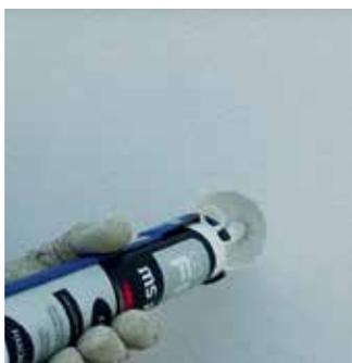
Figura 97 e 98 - Revestimento das buchas de fixação mecânica com EPS
