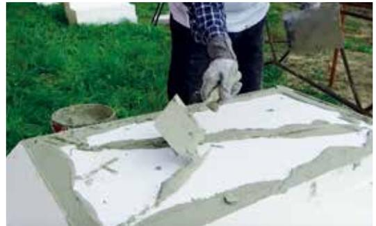
Figura 83 - Aplicação da ARGAMASSA THERMINNOV perimetral com pontos
