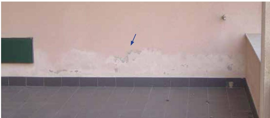
Figura 73 - Parede exterior com humidade ascensional
