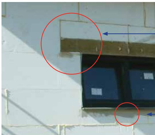
Coincidência das juntas com o vão descompensado.
