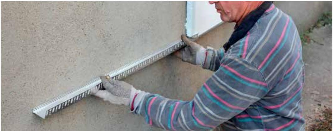
Figura 77 - Colocação do perfil de arranque (cota de segurança para evitar contacto com água do solo)
