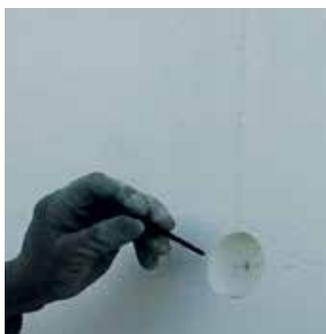
Figura 96 - Colocação da bucha de fixação
