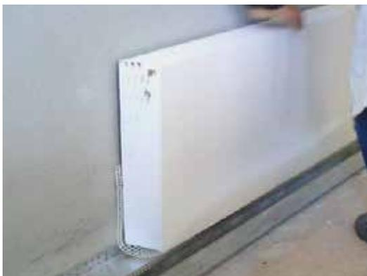
Figura 86 - Primeira fiada de placas com rede de ligação. Evita a fissuração na zona do perfil
