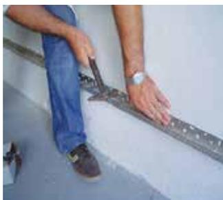
Figura 79 e 80 - Colocação do perfil de arranque.
