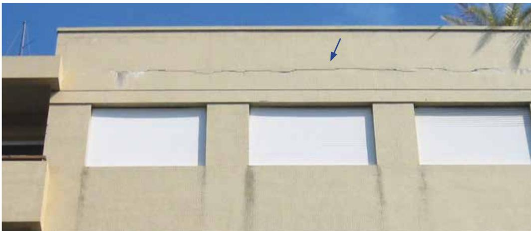
Figura 72 - Fachada com fissuras
