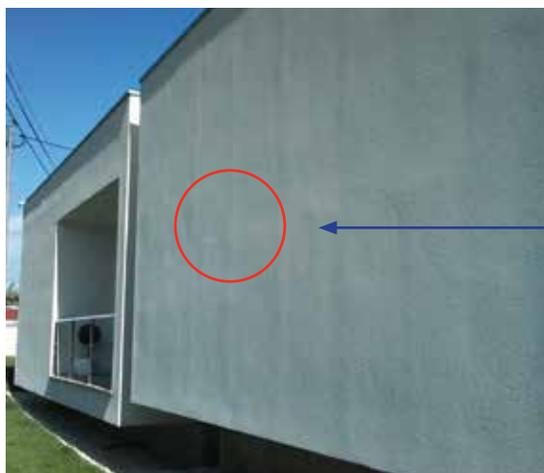
Camada insuficiente de argamassa. Conseguem-se visualizar as sobreposições da rede e as juntas das placas de AIRPOP.
