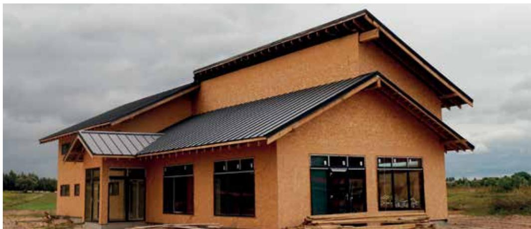
Figura 75 - Construção em placas OSB
