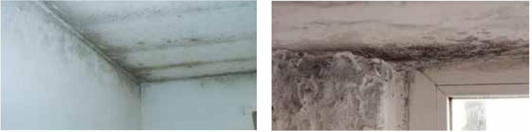
Figura 6 - Tetos e paredes com fungos
