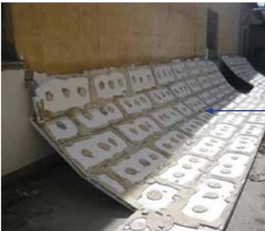
Material de colagem inadequado ao substrato e falta de fixação mecânica das placas do isolante térmico.
